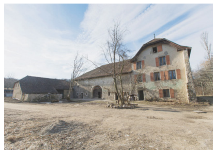
Les travaux de restauration vont pouvoir commencer. ARCH. SIGFREDO HARO
